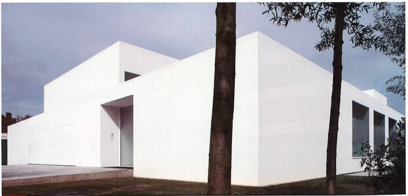
Vanhaerents formuleert een creatief verantwoord en technisch onderbouwd antwoord voor de architect die kiest voor gladde buitenbepleistering. Gladde buitenbepleistering vindt almaar meer zijn weg in de hedendaagse architectuur.
