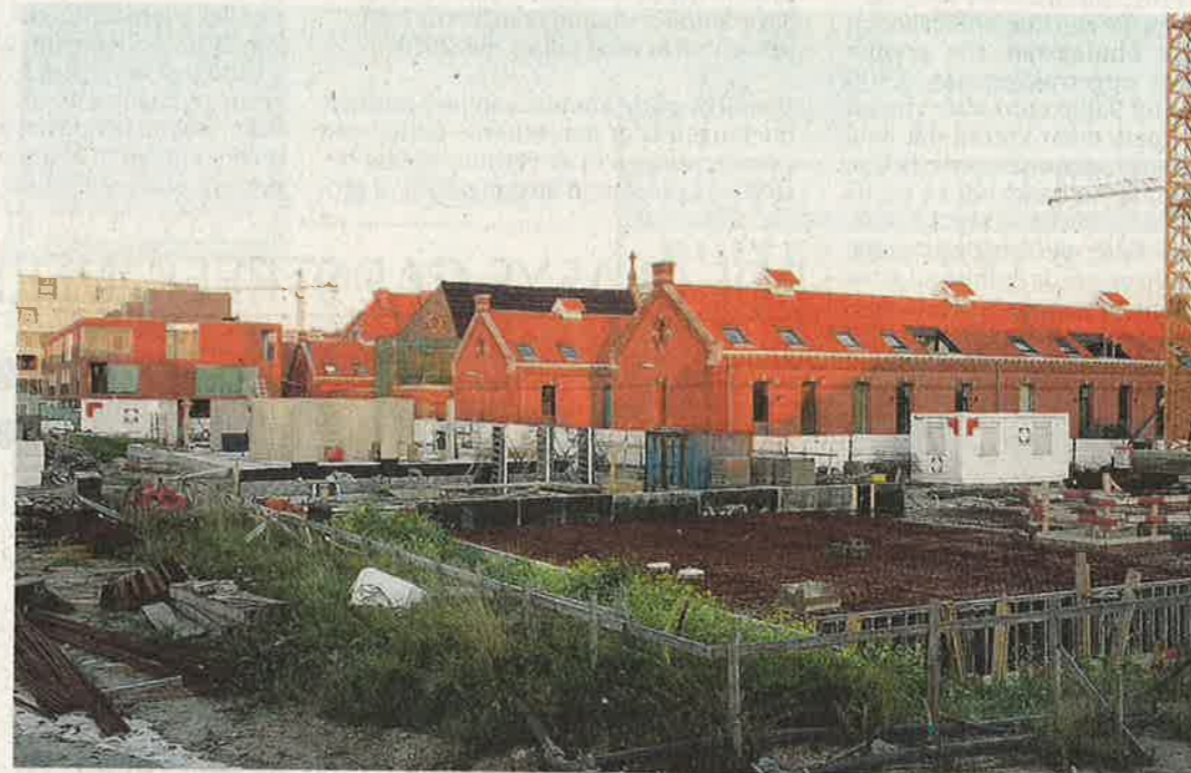
De site van het voormalige Militair Hospitaal, waar wonen en erfgoed hand in hand gaan, noemt architect Marc Martens een voorbeeld voor de hele kust. Foto Proot
